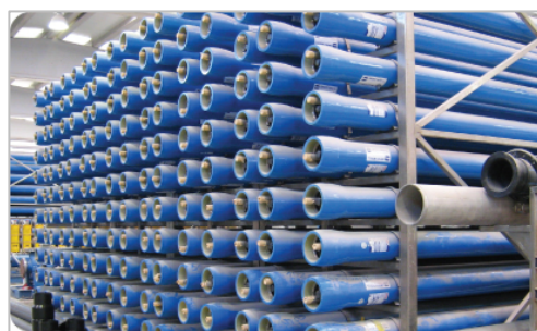
Ilustración 4: Rack de tubos de presión de osmosis inversa (Fuente: Lenntech)
